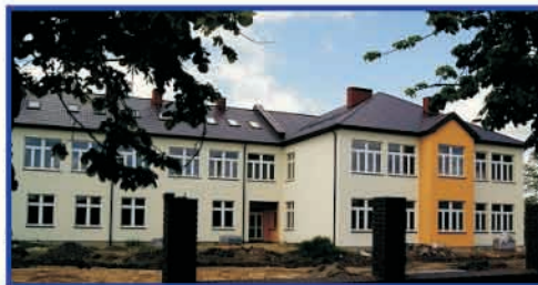
Prace wykonywane w trakcie II etapu budowy.
