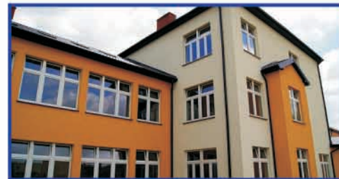
Fragment budynku nowo wybudowanej siedziby Gimnazjum Gminnego.
