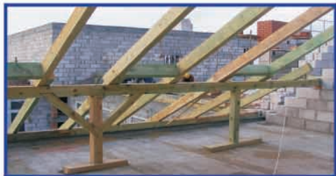
Prace wykonywane podczas realizacji I etapu budowy - wykonanie stanu surowego zamkniętego.
