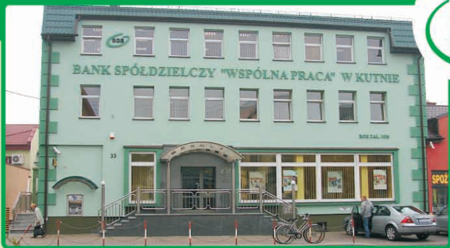
Bank Spółdzielczy "Wspólna Praca" w Kutnie po modernizacji (z dobudowanym piętrem i nową elewacją).
